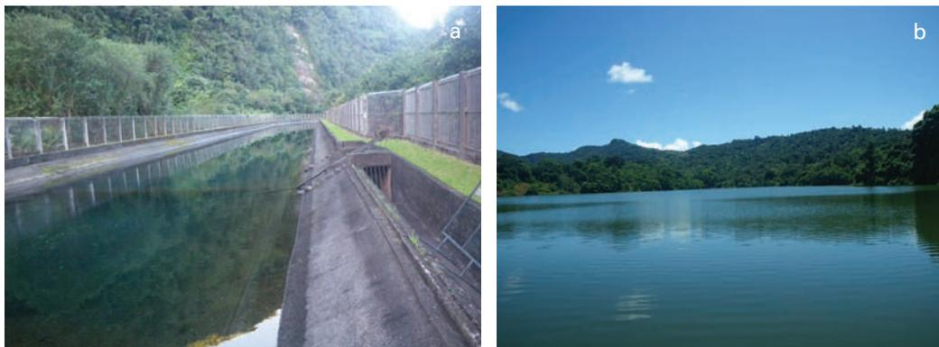
Exemples de ralentissement des écoulements provoqué par certains ouvrages, pouvant impacter la dévalaison suite à une décantation des individus dévalants.
