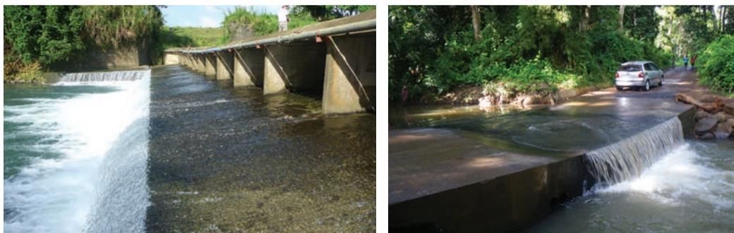
Écoulement sur un parement incliné présentant une chute aval.
