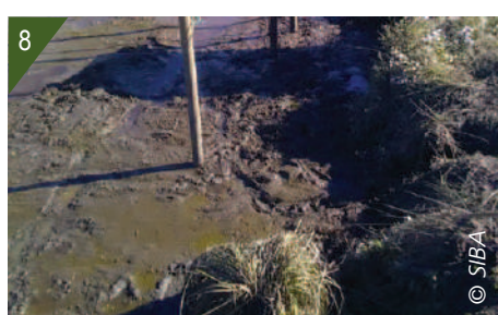
3 - Mise en place du barrage filtrant.
