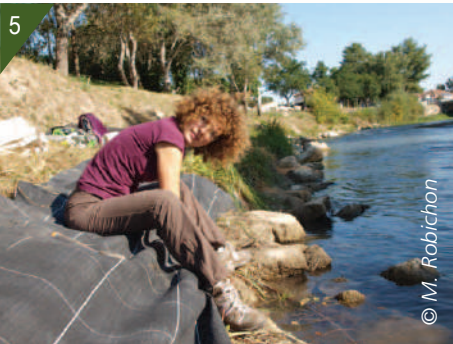
5 - Mise en place de la bâche.
