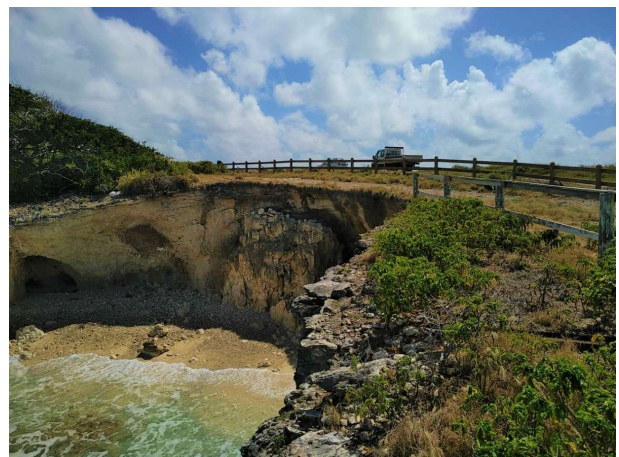
Nouveau garde-corps (sur la droite, un vestige de l'ancien, tombé avec l'effondrement)
