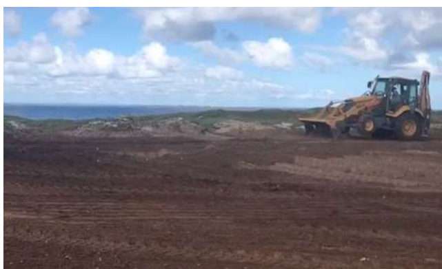
Opération de décompactage en septembre 2019
