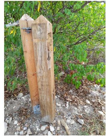
Dégradation de la barrière pivotante
